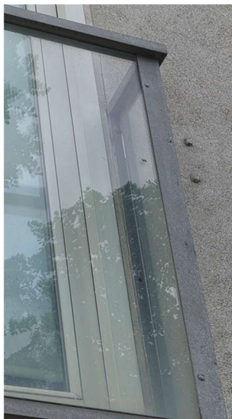
Figur 3.4 Altan på 1. sal. Altanerne er monteret med 3 skruer i hver side, dog mangler de midterste skruehoveder nogle steder, som vist i figuren.
