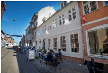
Figur 5. Eksempel på omdannelse fra kontorbygning til privat service. Fredet ejendom på 529 m 2 , opført i 1735. Større ombygning i 2016, anvendelsesskift i 2017 (Kyhns Gæstehus i Helsingør, indstillet til Renoverpris i 2019).
