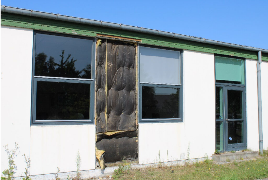
Figur 11. Facadeelement udtaget.
