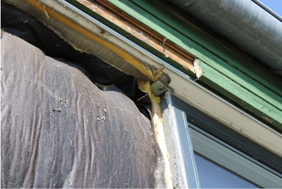
Figur 13. Facadeelement udtaget. Bemærk lille stålplade benyttet til fastholdelse af facadeelement (ikke korroderet).
