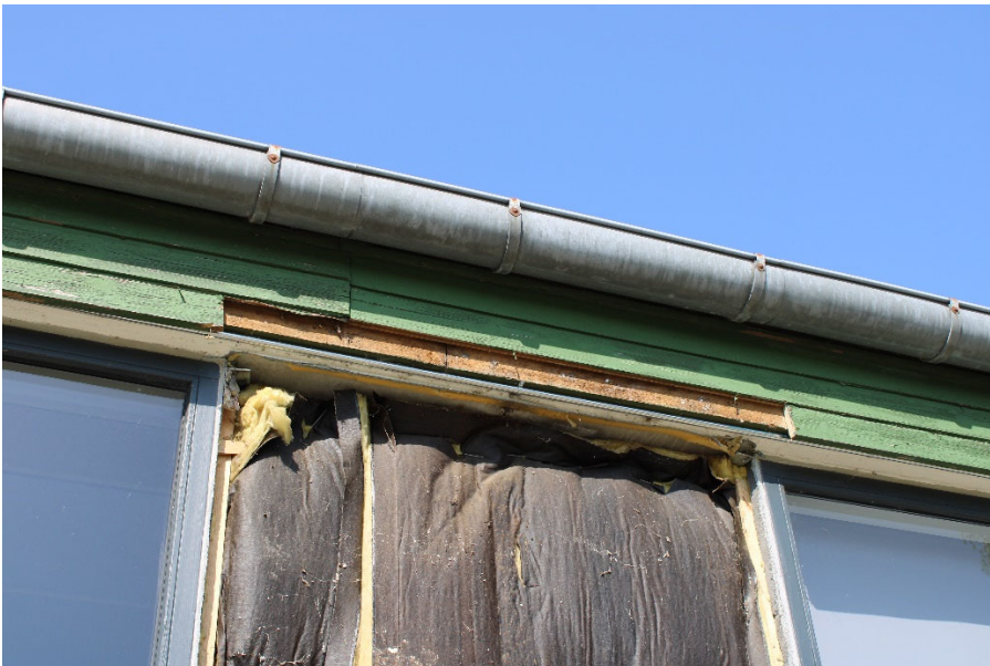
Figur 12. Facadeelement udtaget.
