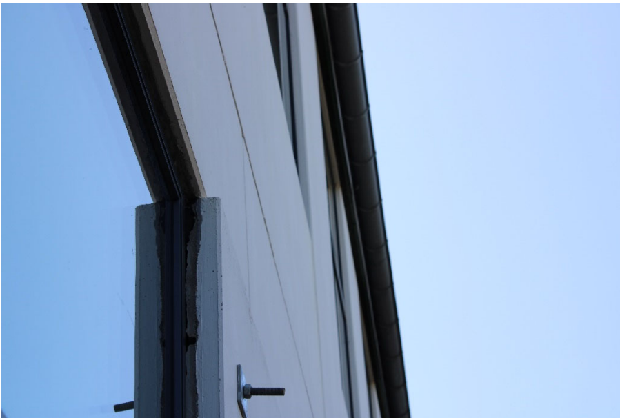
Figur 10. Facadeelement i nederste etage. Bemærk udbøjning af top af nederste facadeelement.
